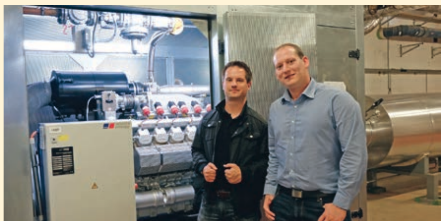
Abb. 2 Die Stadtwerke-Mitarbeiter Christian Launhardt und Patrick Wattenbach präsentieren das vierte BHKW-Modul. Der Magerturbo-Gasmotor mit einer Leistung von 1060 \text{ kW}_{\text{prim}} erzeugt 385 \text{ kW}_{\text{el}} und 311 \text{ kW}_{\text{th}} . Die Abwärme wird im nachgeschalteten Wärmetauscher genutzt, die Austrittstemperatur des Abgases liegt bei 57 \text{ °C} .
